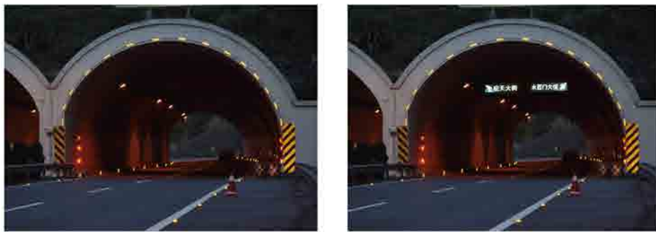
图 2-15 隧道内设LED突起路标、LED轮廓标、隧道内指示标志示例
