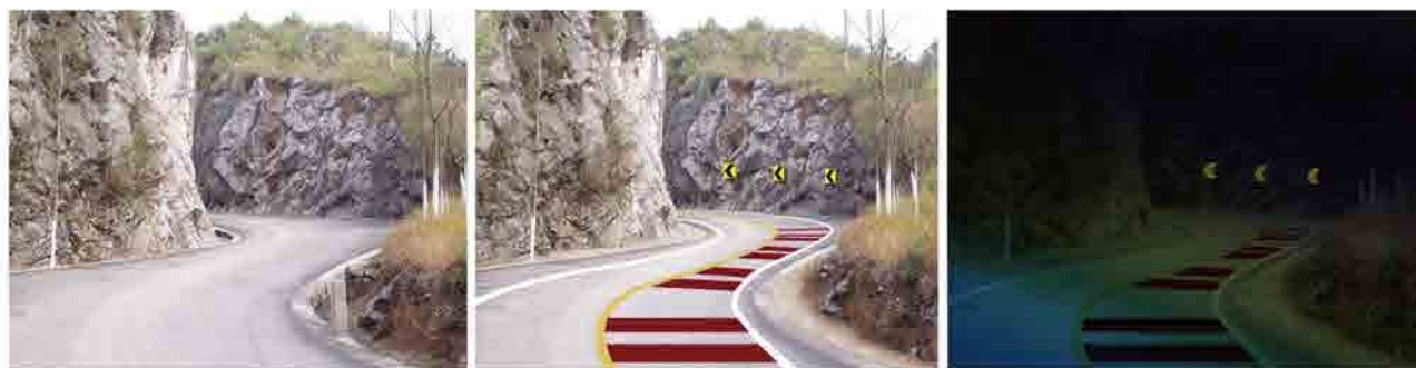
图 2-5 连续急弯路段标志改进前后对比图示例
