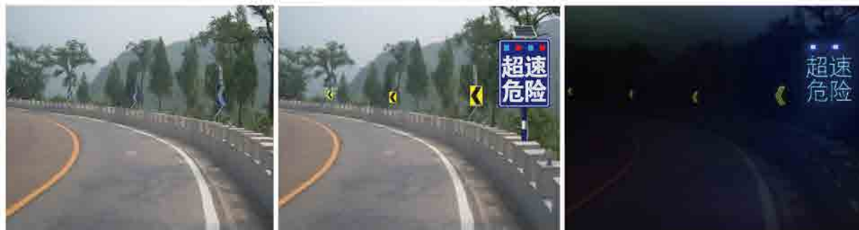
图 2-10 直桥接小半径曲线路段标志改进前后对比图示例
