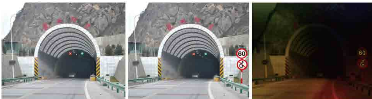
图 2-14 隧道入口处标志改进前后对比图示例
