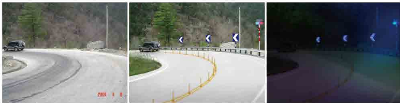
图 2-4 单个急弯路段标志改进前后对比图示例
