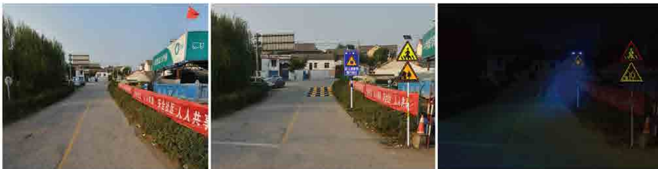
图 2-1 穿越学校、集镇、村庄路段标志改进前后对比图示例一
