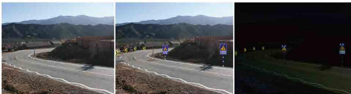
图 2-12 穿村路段与视距不良的急弯路组合路段标志改进前后对比图示例
