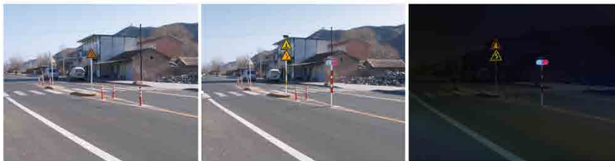
图 2-2 穿越学校、集镇、村庄路段标志改进前后对比图示例二
