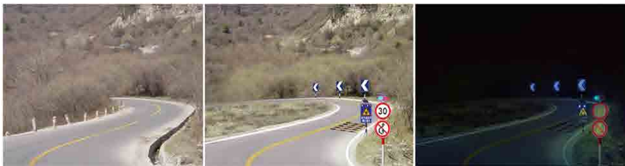
图 2-6 视距不良路段标志改进前后对比图示例
