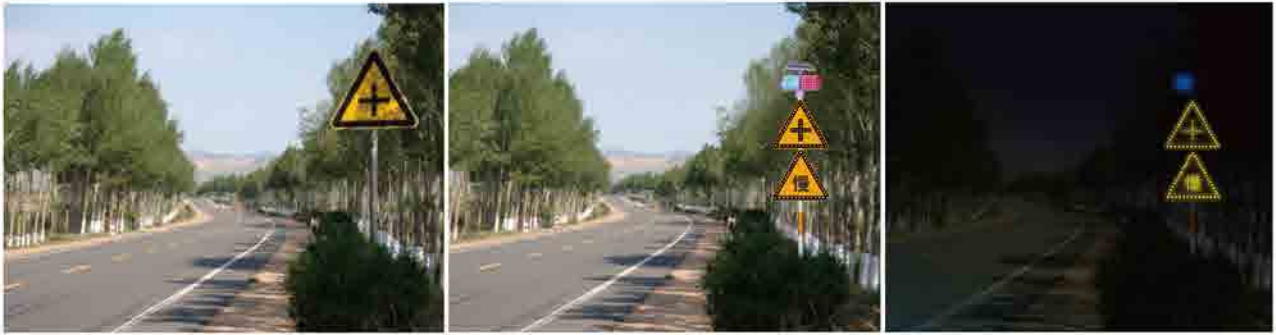
图 2-17 平交路口主路标志改进前后对比图示例二
